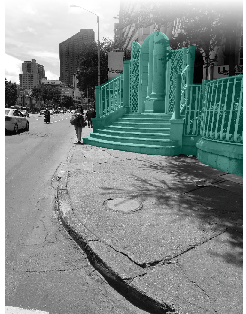
Imagen 3. Paramento de edificación Elaboración Propia
