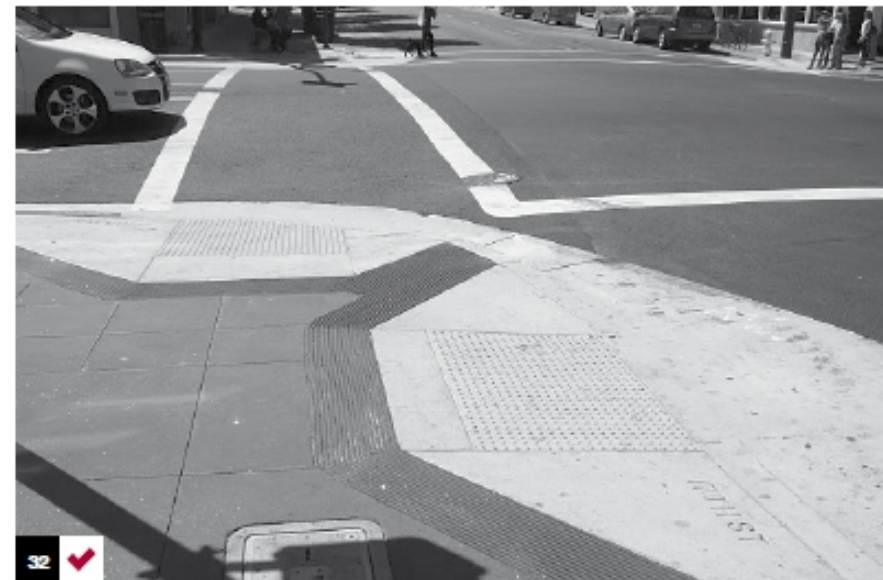
Foto 32: rebaje en esquina con una pendiente adecuada. Las alas laterales también se desarrollan con buena pendiente para no interferir con la circulación peatonal. La textura de advertencia indica la proximidad del cruce delimitado en la calzada. San Francisco, EE.UU.
