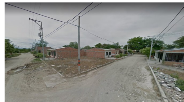
Figura 34. Localización UUPH D y foto sector Cll 9 N 27; Recuperado de Google map.
