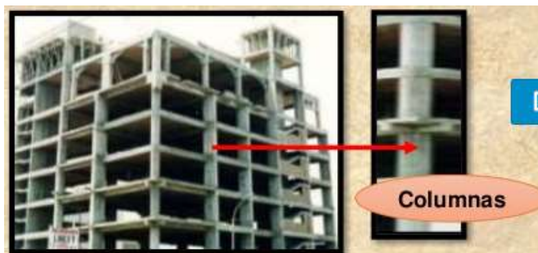
Figura 85: Características Sistema constructivo aporticado
