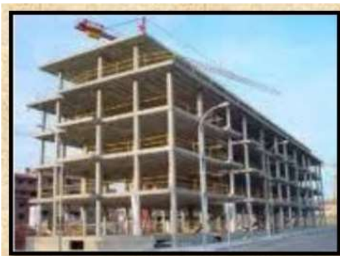
Figura 81: Características Sistema constructivo aporticado
