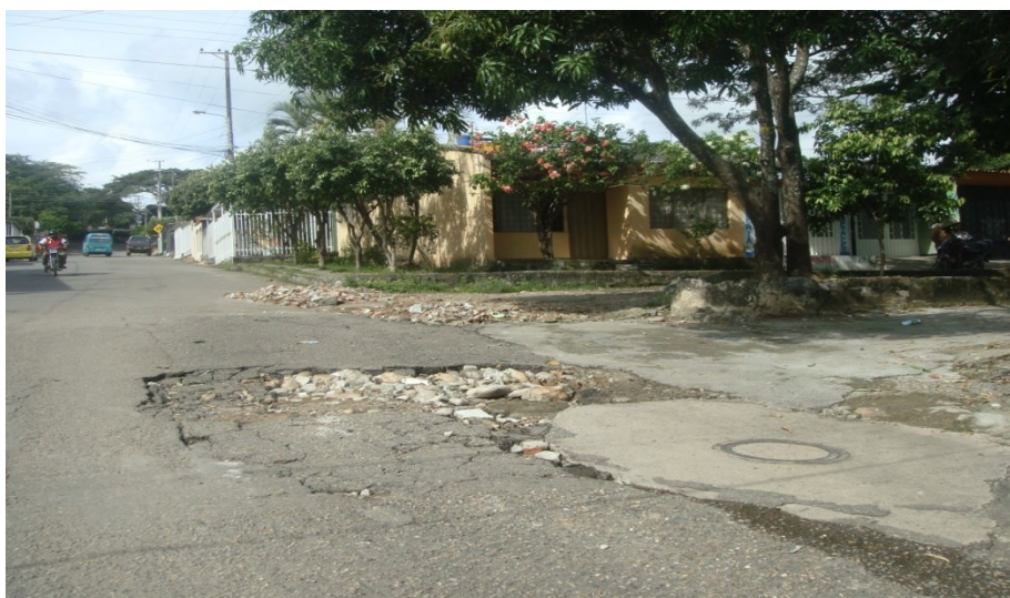
Figura 39. Calle 21 con carrera 30 barrio los parques.
