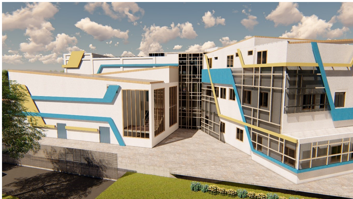
Fuente: autor Ilustración 40 vista posterior del edificio.
