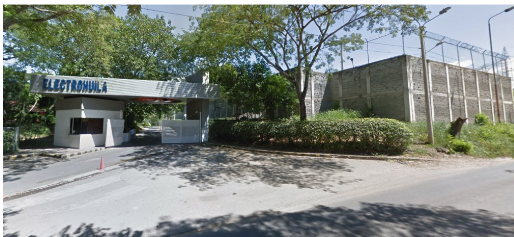
Ilustración 4: Existencia de la Sub- Estación; fuente: Google map.
