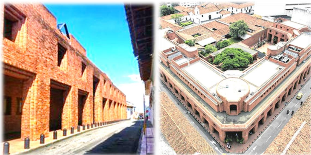
Ilustración N°74. Fotografías del Edificio Antigua FES – Fundación para la educación superior.
