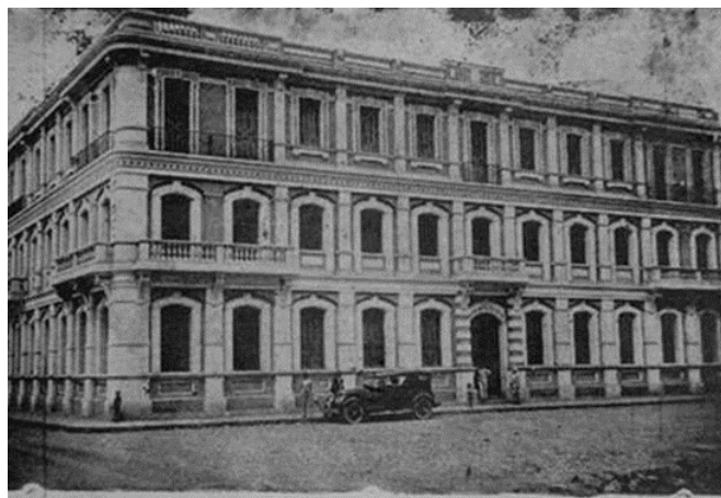
Ilustración N°3 – Edificio antiguo de la alcaldía - Palmira, Valle del Cauca 1935.
