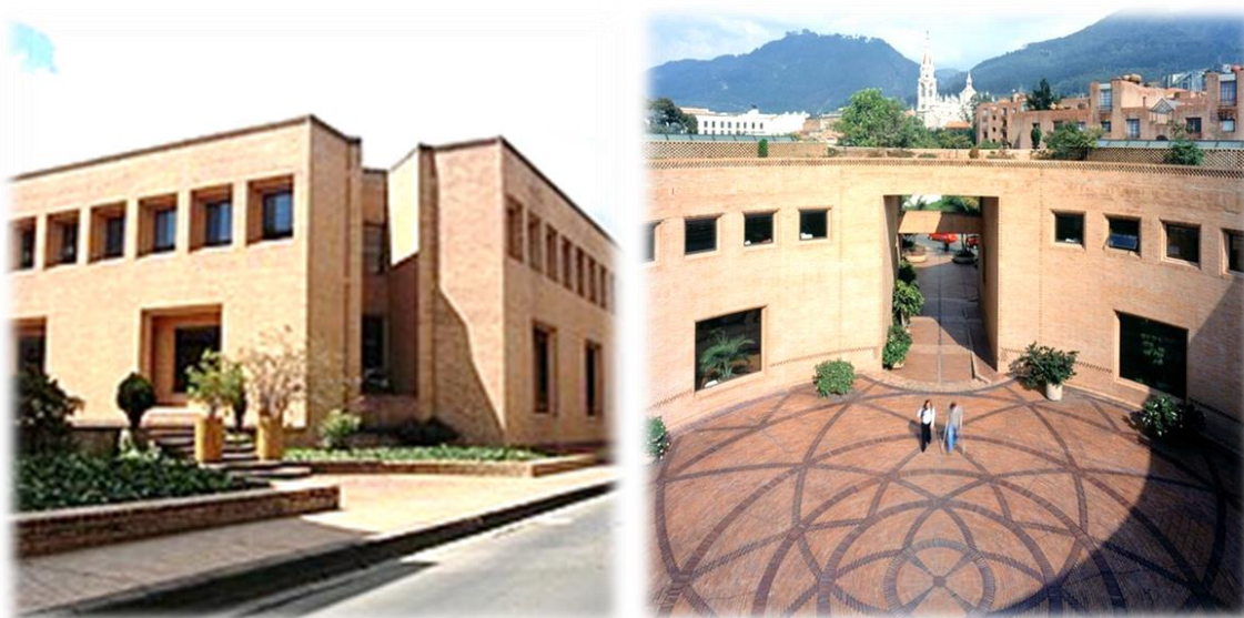
Ilustración N°71. Fotografías del Edificio del Archivo General de la Nación.
