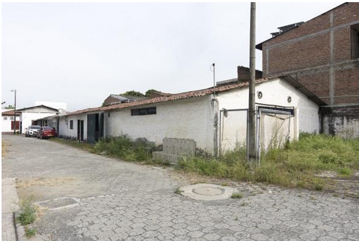
Ilustración N°6: Bodega localizada en el antiguo matadero municipal, propuesto como nueva sede del archivo municipal. Fuente propia.
