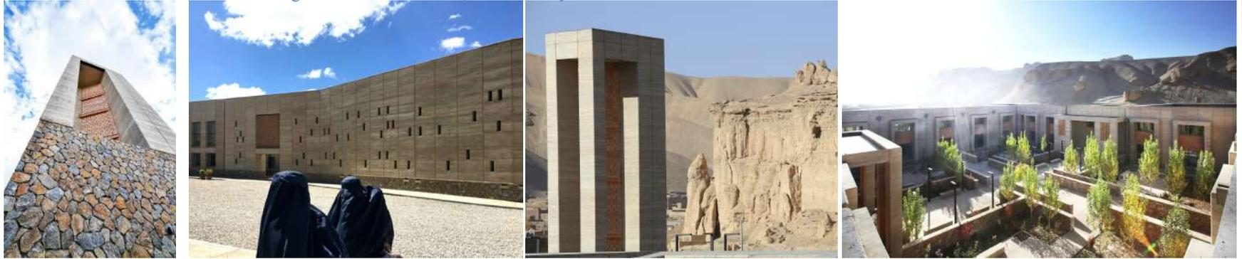
Se emplearon soluciones de construcción híbridas para cumplir con las exigencias sísmicas en un área de alto riesgo, se usaron prácticas tradicionales de construcción, la tierra apisonada estabilizada se usa como paredes externas, se empleó mano de obra local y se entrenó para en una forma de construcción de tierra más duradera.
