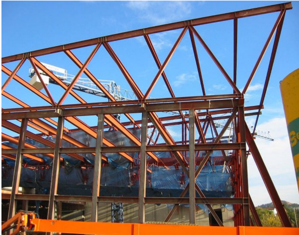
Figura 24. Estructura de fachada, (Arquitectos, CosmoCaixa Barcelona, s.f.)
