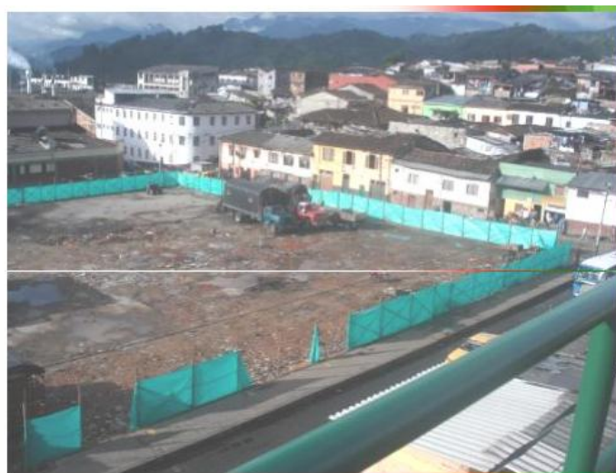
Figura 7. Lote Antes de la Construcción del Ahora actual Terminal Mixto
