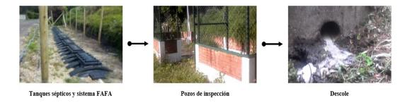
Figura 10 Esquema de funcionamiento del Sistema de Tratamiento de Aguas Residuales (STAR) La Yerbabuena. .
