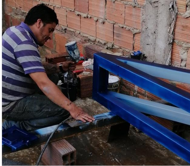
*Figura 55 Proceso de pintura anticorrosiva y esmalte.*
