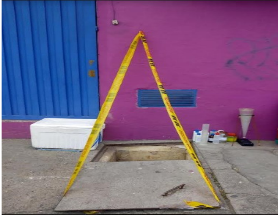
Figura 13. Señalización de la caja de inspección donde se tomaron las muestras para formación de la muestra compuesta. Fuente: Autor.
