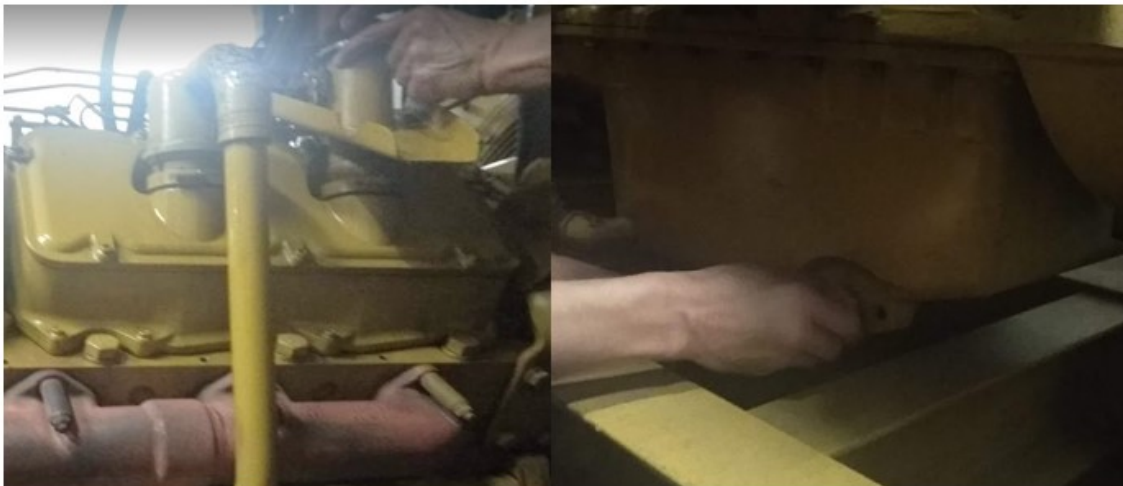
Figura 22: Suministro de aceite a la planta de suministro de energía Fuente: Autor
