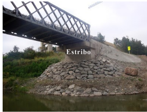
Figura 3. Momentos M. (2017). Estribo puente, fotografía tomada y modificada de http://momentosdemohr.blogspot.com/2017/12/estribos-de-puentes.html
