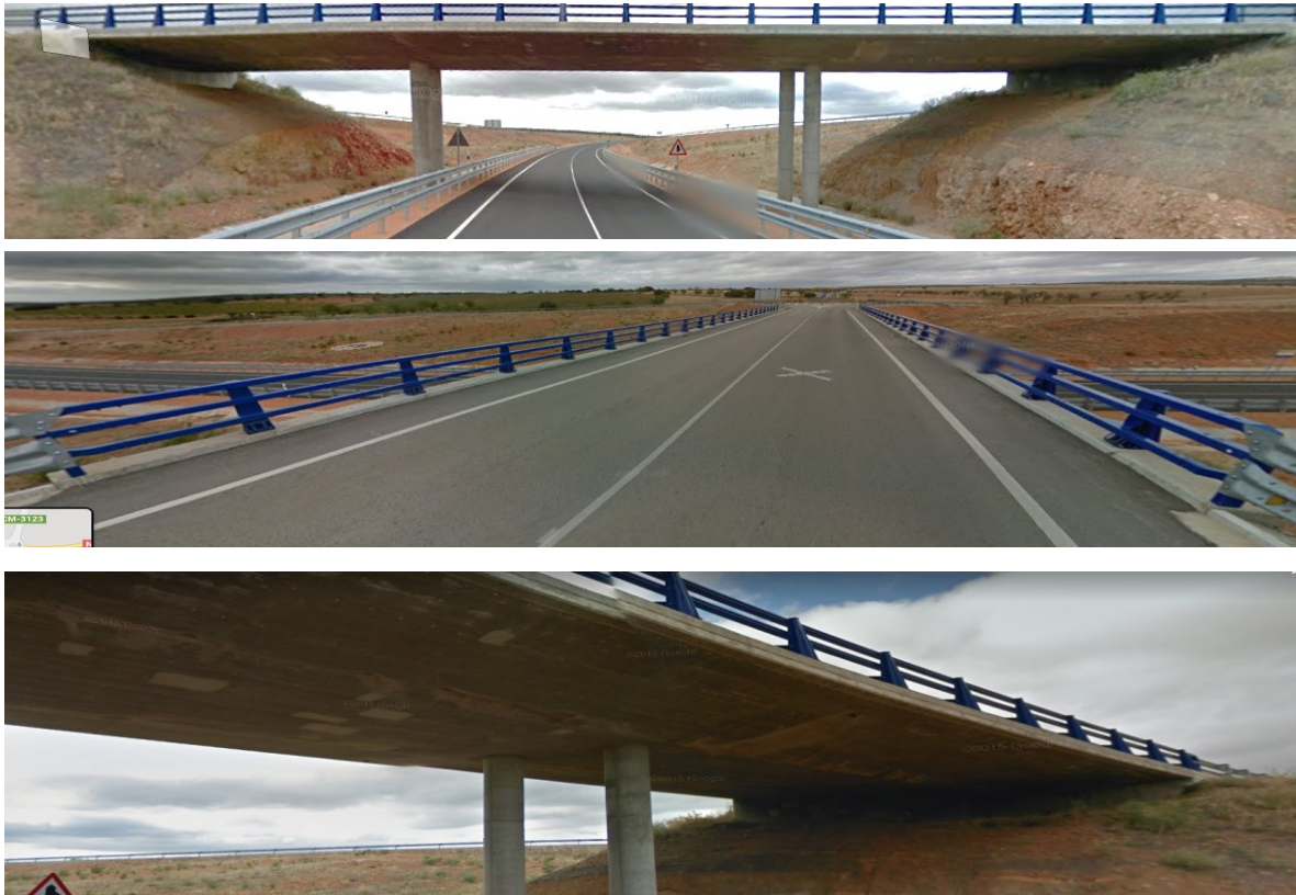
Figura 19 Google Maps visualizada en (2020), Puente Integral De la ruta N-43 de la variante en Ossa de Montiel, España. Recuperado y Adaptado de Google Maps.
