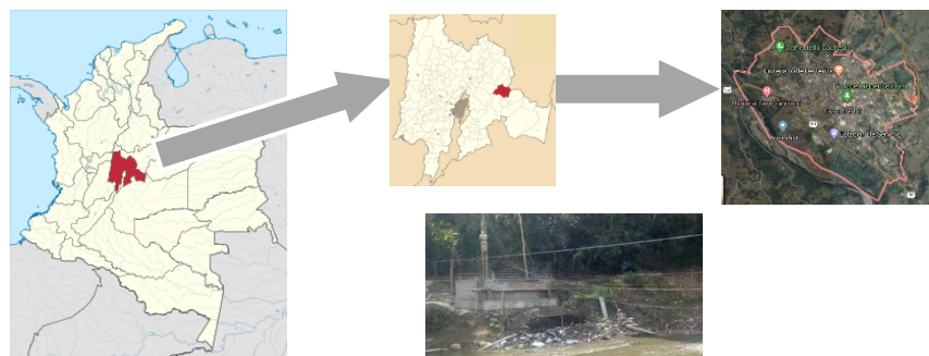
Figura 32 Adaptación propia. (2020). Localización de puente vehicular en la vereda Cusaquin, sector puente cubierto del municipio de Gacheta.
