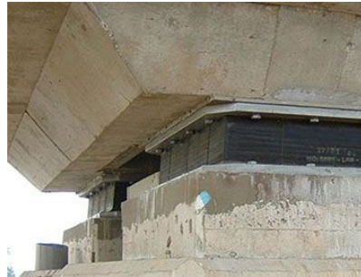
Figura 10 Ricardo C. (2020). Fotografía de apoyos elastómeros Tomada de https://co.pinterest.com/pin/531284087286504857/
