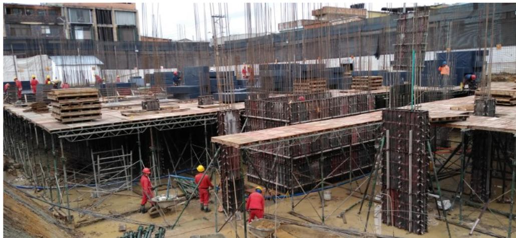
Figura 25. Encofrado Columnas y Pantallas Edificio Sorrento
