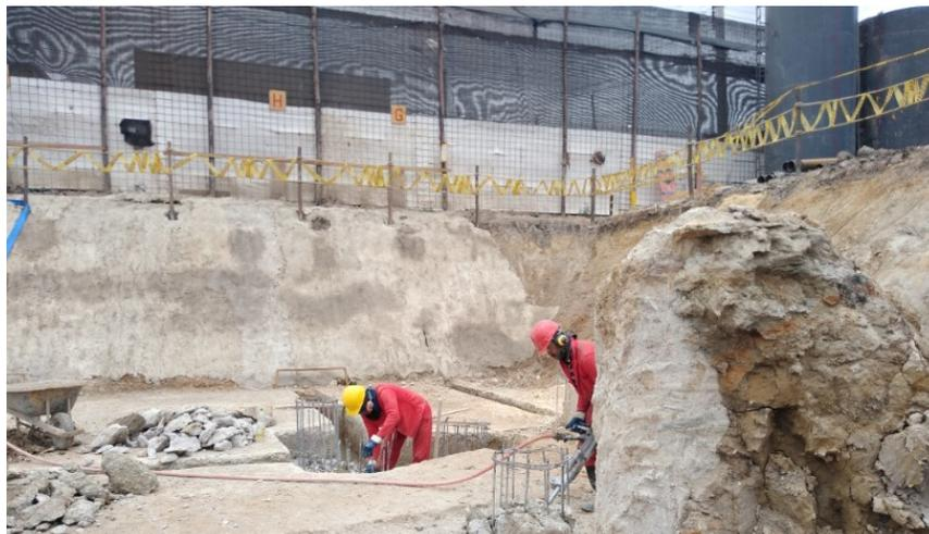
*Figura 19.* Pañete de taludes y Delimitación del Área Excavada
