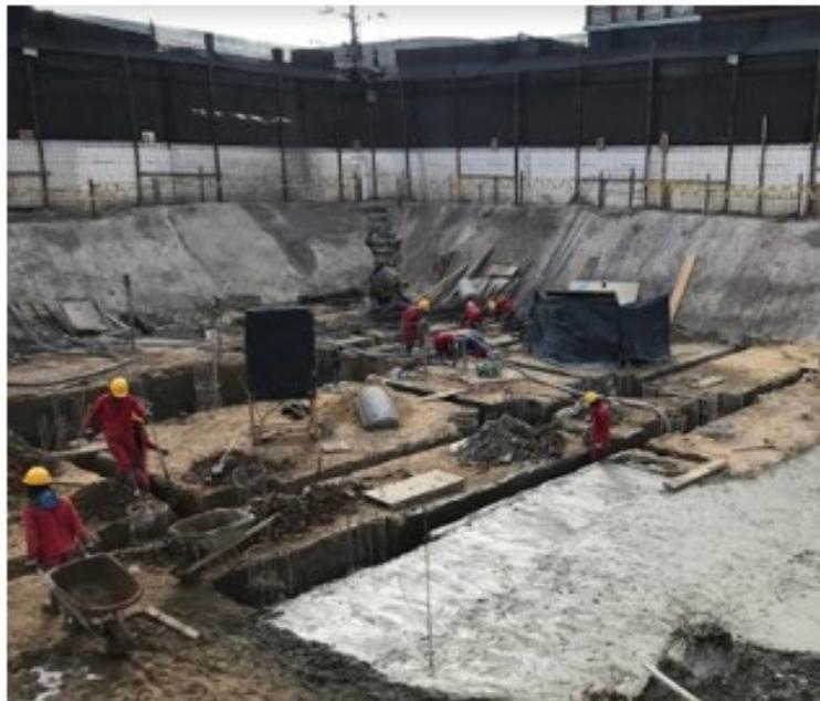
*Figura 21.* Excavación Manual de Vigas y Dados de Cimentación
