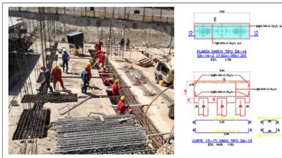
*Figura 23.* Amarre de Acero de Refuerzo Para Vigas y Dados de Cimentación
