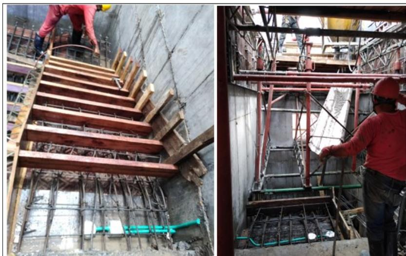
*Figura 29.* Armado y Fundida de la Escalera de Acceso
