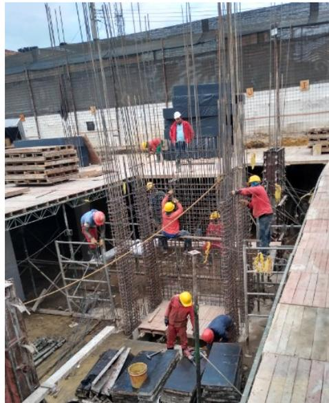
*Figura 24* Amarre de acero de refuerzo de Columnas y Pantallas
