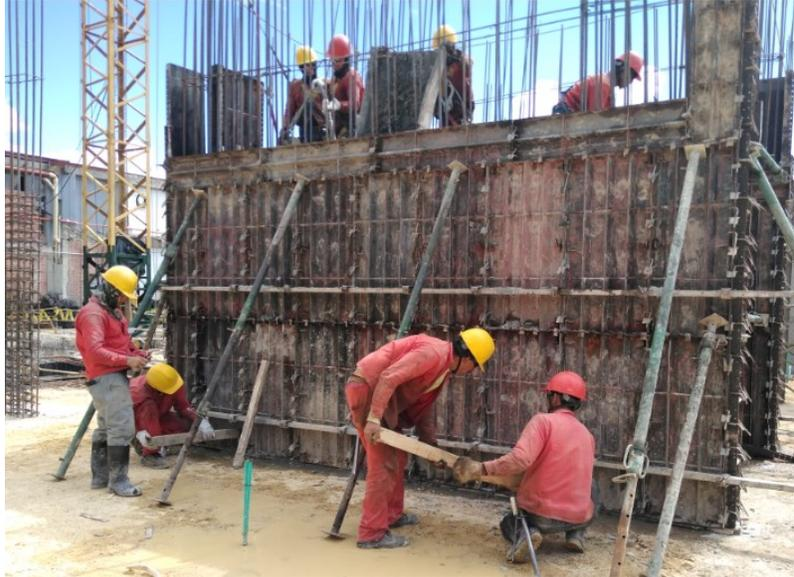
*Figura 26.* Vaciado de concreto hidráulico para columnas y pantallas
