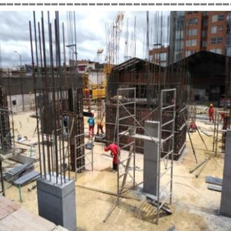
F20. Armado y fundida de columnas piso 1 a 2
