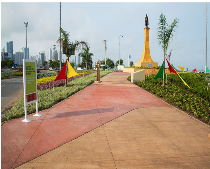
Figura 3. Concreto Permeable en Glorieta Santander- Cartagena Tomado de Argos (2015)
