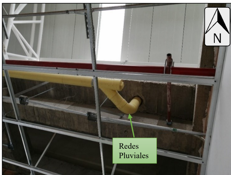
Figura 46. Instalación de Red Pluvial en Viga Canal
