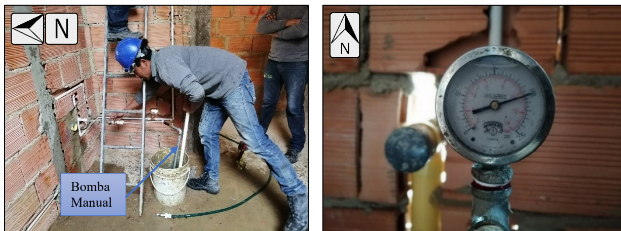
Figura 52. Prueba Hidrostática en Sistema de Suministro de Agua Potable
