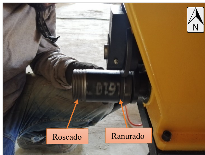
Figura 58. Elaboración de Ranuras y Roscas en la Tubería
