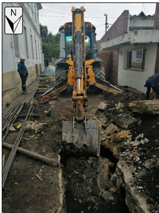
Figura 60. Excavación para Acometida
