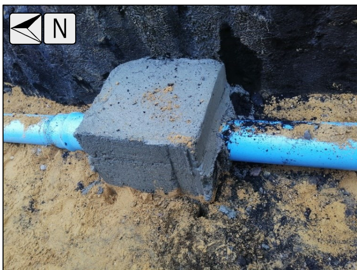
Figura 62. Instalación de Bloques de Inercia
