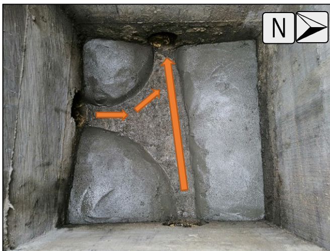
Figura 49. Instalación de Media Cañas en Cajas de Inspección
