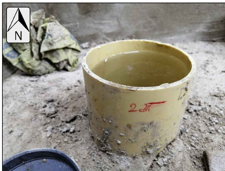
Figura 47. Prueba de Estanqueidad en Red Sanitaria Segundo Piso
