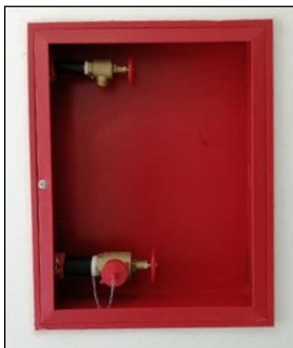
Figura 66. Instalación de Gabinetes Tipo III
