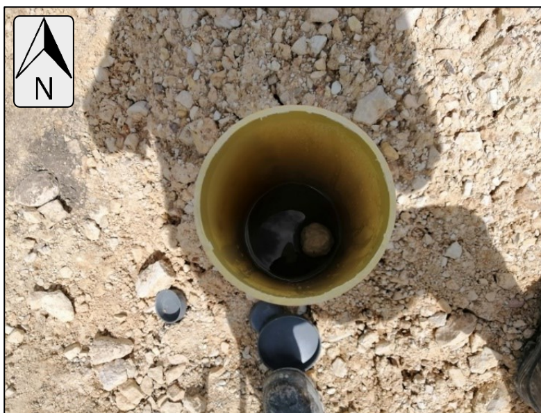
Figura 48. Prueba de Flujo en Red Sanitaria Primer Piso
