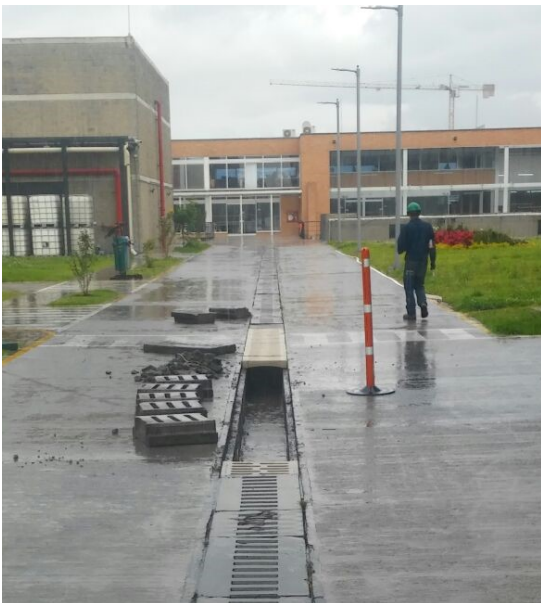
Fotografía propia- Reemplazo Tapas cárcamos- Planta Pegatex [Figura 22].
