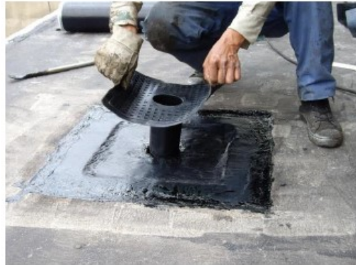
Mastertech SAS. (2016). Montaje En Bajantes De 4" De Tragantes De EPDM [Figura 17]. Recuperado de Ficha Técnica Montaje En Bajantes De 4" De Tragantes De EPDM
