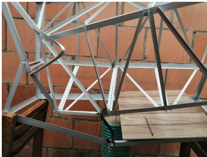
Ilustración 23 Torsión en diagonal estructura No. 2
