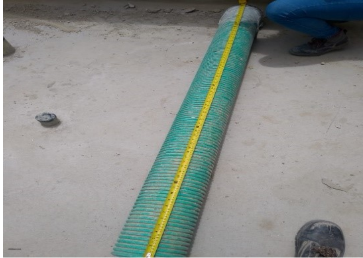
Ilustración 16 Tubo 4 pulgadas para pesas
