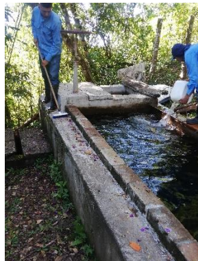
Evidencia fotográfica 3, mantenimiento al desarenador general por la ESP Acuavalle, 17 enero 2020
