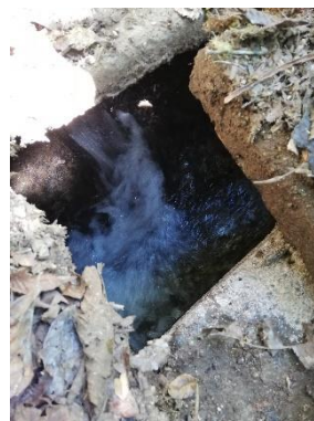
Evidencia fotográfica 24, Caja de lavado desarenador La Florida - 17 enero 2020.
