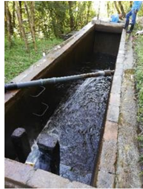
Evidencia fotográfica 8, Vaciado del desarenador general para mantenimiento-17 enero 2020.
