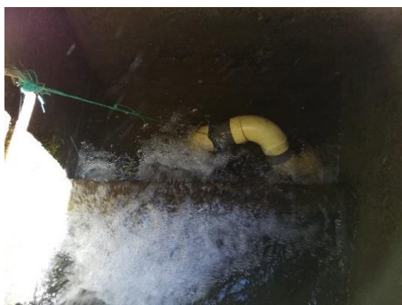
Evidencia fotográfica 31, Vertedero de salida en la caja de derivación bocatoma La Florida - 17 enero 2020.
