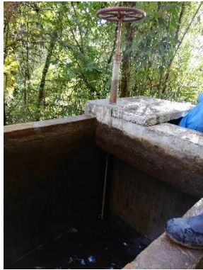
Evidencia fotográfica 7, Válvula de lavado del desarenador general, 17 enero 2020.
