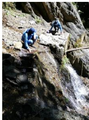
Evidencia fotográfica 28, Caja de derivación, Rejilla y canal de aducción Bocatoma la Florida - 17 enero 2020.
