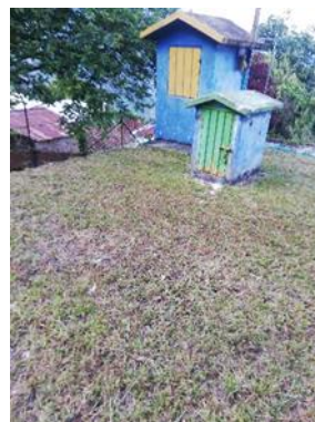
Evidencia fotográfica 34, Caseta de Cloración y medición de flujo - 23 de febrero 2020.
