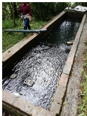
Evidencia fotográfica 11, Verificación de funcionamiento desarenador general- 28 de febrero 2020.
