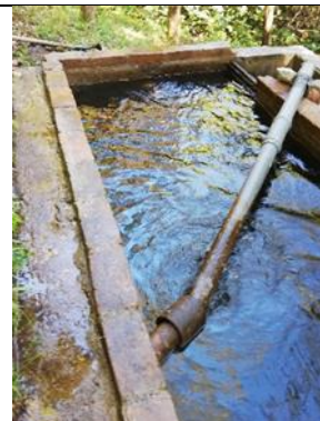
Evidencia fotográfica 4, paso directo al rebose del agua sedimentada por el desarenador la florida al rebose- 17 enero 2020.
