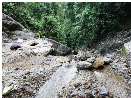
Evidencia fotográfica 27, Rejilla y Caja de derivación bocatoma La Florida - 17 enero 2020.
