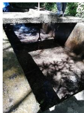
Evidencia fotográfica 22, Desarenador La Florida durante el mantenimiento-17 enero 2020.
