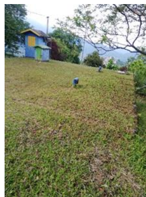
Evidencia fotográfica 32, Tanque de almacenamiento de la cabecera municipal – 23 de febrero.
