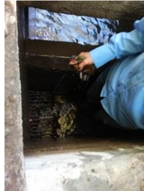
Evidencia fotográfica 6, Mantenimiento del vertedero de salida del desarenador general-17 enero 2020.
