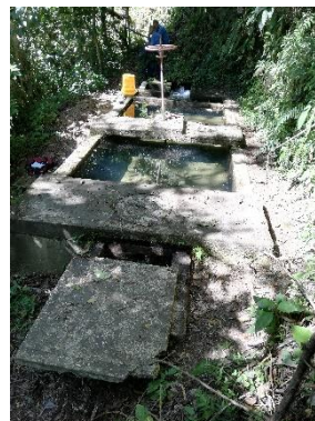
Evidencia fotográfica 18, Desarenador La Florida vista general - 17 enero 2020.
