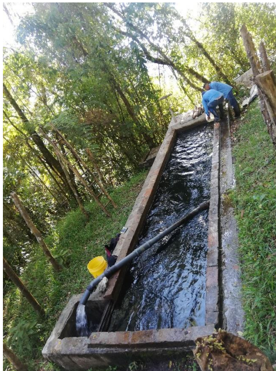
Imagen 6 Desarenador general, fuente: tesista
