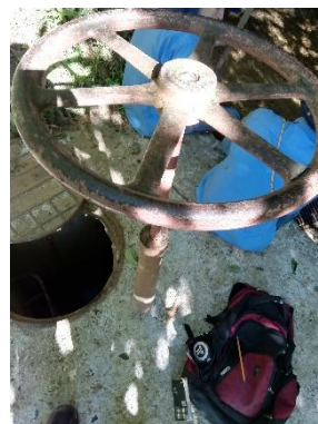
Evidencia fotográfica 16, Válvula de Lavado de la bocatoma Volconda.
