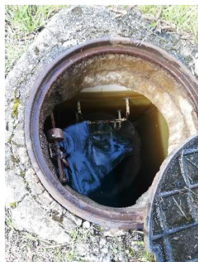
Evidencia fotográfica 35, Manhole tanque de almacenamiento - 23 de febrero 2020.
