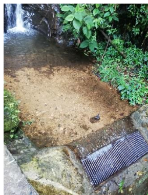
Evidencia fotográfica 17, Bocatoma Volconda después del mantenimiento- 28 febrero 2020.
