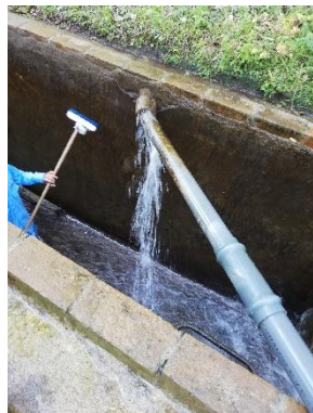
Evidencia fotográfica 9, Mantenimiento al desarenador general- 17 enero 2020.
