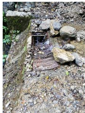
Evidencia fotográfica 30, Rejilla Bocatoma La Florida - 17 enero 2020.
