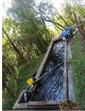
Evidencia fotográfica 1, desarenador general 17 de enero 2020
