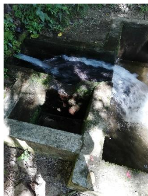
Evidencia fotográfica 21, Rebose desarenador La Florida en el momento del mantenimiento - 17 enero 2020.
