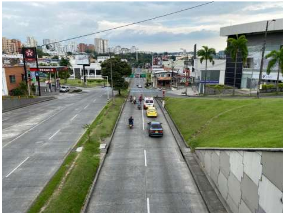
Fotografía 2. Vista general carrera 17 en la actualidad.
