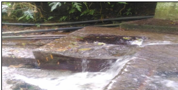
Imagen 7. Segundo sistema de captación de la bocatoma de Pital.
