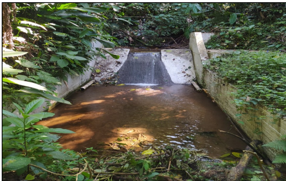
Imagen 8. Bocatoma sistema Monos. mostrando tanque de amortiguación y azud
