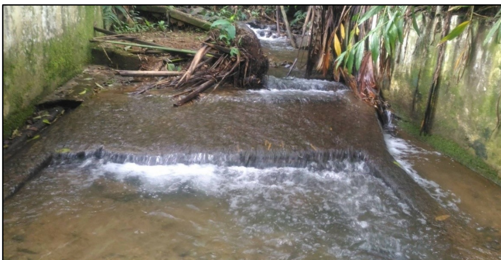
Imagen 6. Localización de primera rejilla de la bocatoma.
