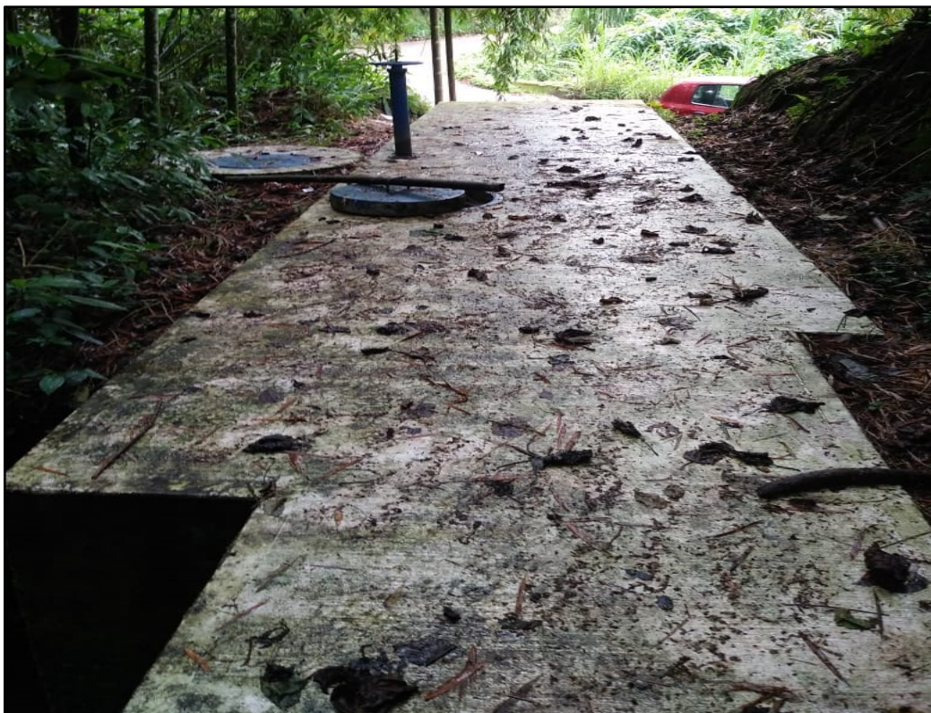
Imagen 4. Desarenador bocatoma Pavas
