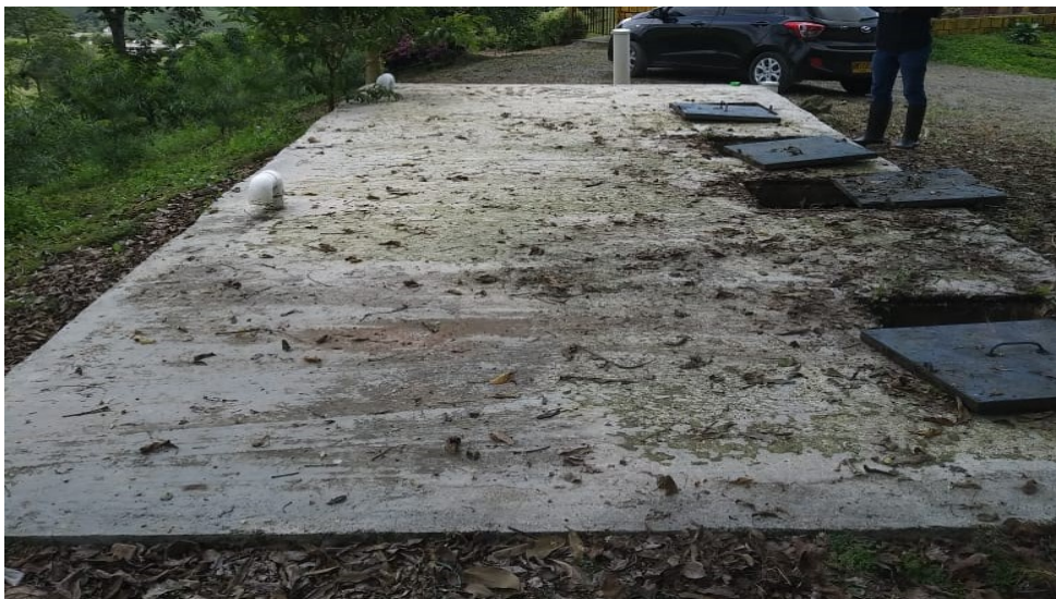
Imagen 5. Desarenador principal del sistema de San Vicente.
