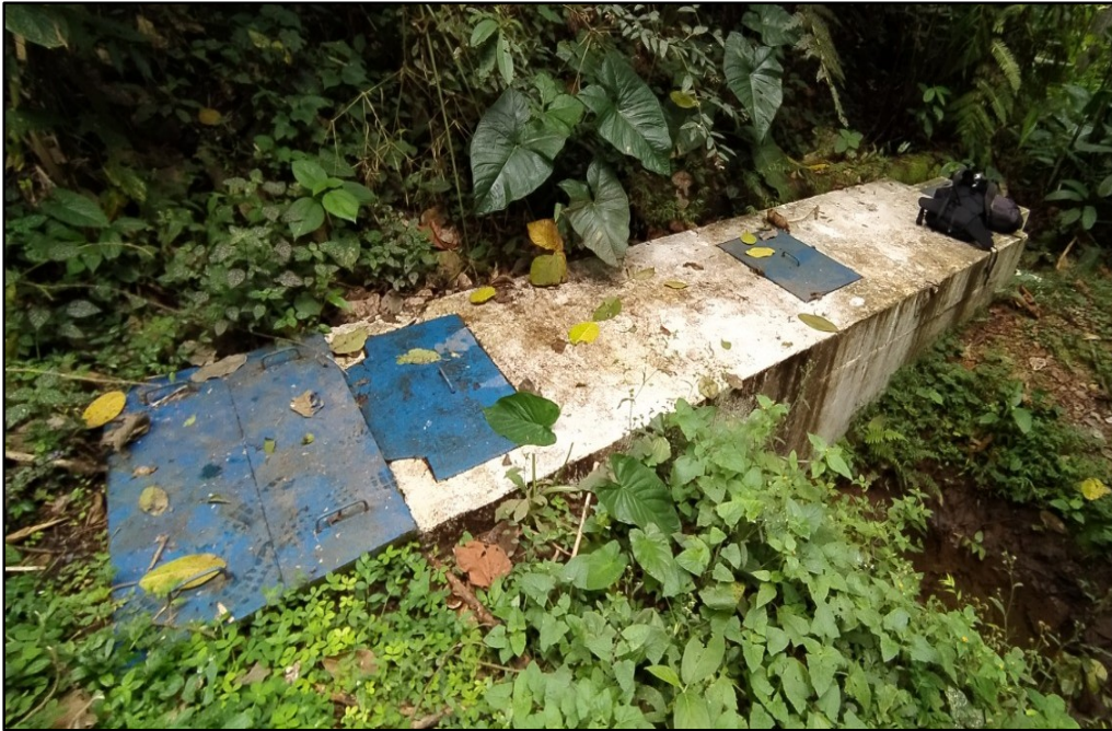
Imagen 9. Desarenador de Sistema Monos.
