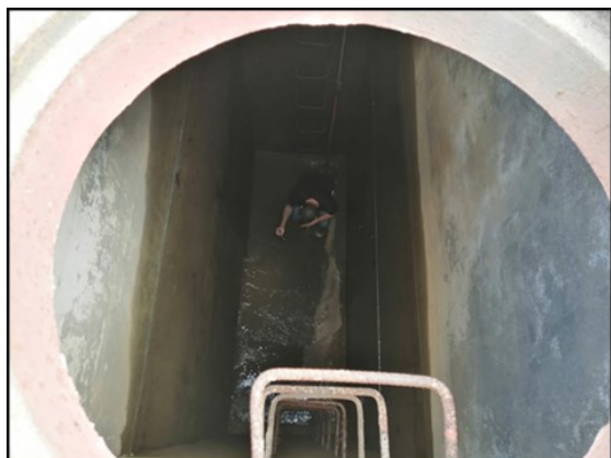
Figura 24. Tanque de agua filtrada:
