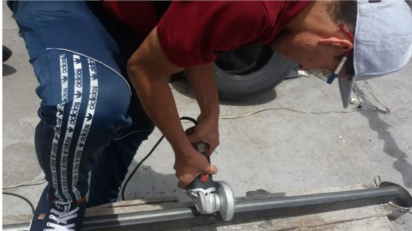
El proceso que continua después del corte de cada uno de los elementos que conformaran el soporte de viga, es realizar un pre – armado y apuntalado de cada uno de los tramos que conformaran esta base.
