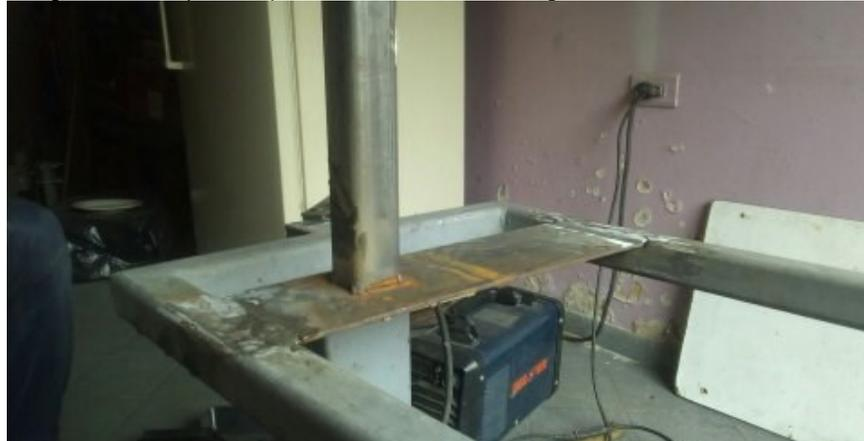
Para dar refuerzo a esta adaptación fue necesario ubicar en su parte inferior cartelas que irán soldadas a la platina instalada y a la estructura. para finalizar el proceso de sujetar las bombas de diafragma se utilizarán platinas de sujeción atornilladas al tubo instalado.
