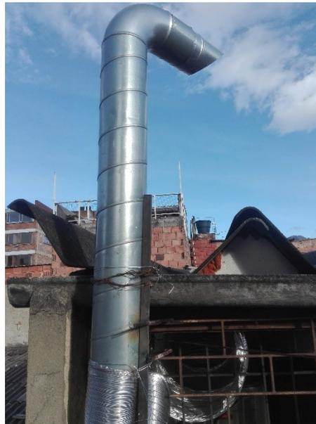
La ubicación de la salida del extractor se hace 1 metro por arriba del techo de las instalaciones, con un protector y diseño curvo para evitar la entrada de agua lluvia por la tubería y dañe el extractor (ver **Figura 4-6 y 4-7**).
