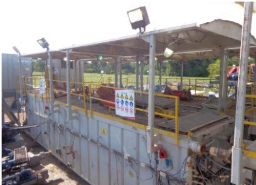
Figura 4.2-12: Tanque de lodos equipo de perforación
