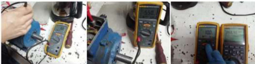
Figura 30 Medida de aislamiento en motores. Fuente propia
