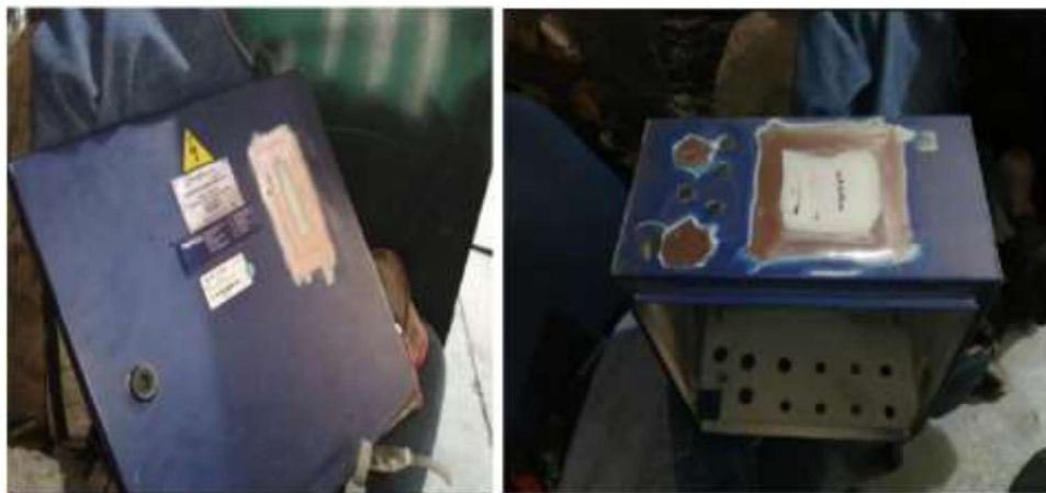
Figura 27 Reparación tablero secundario. Fuente propia
