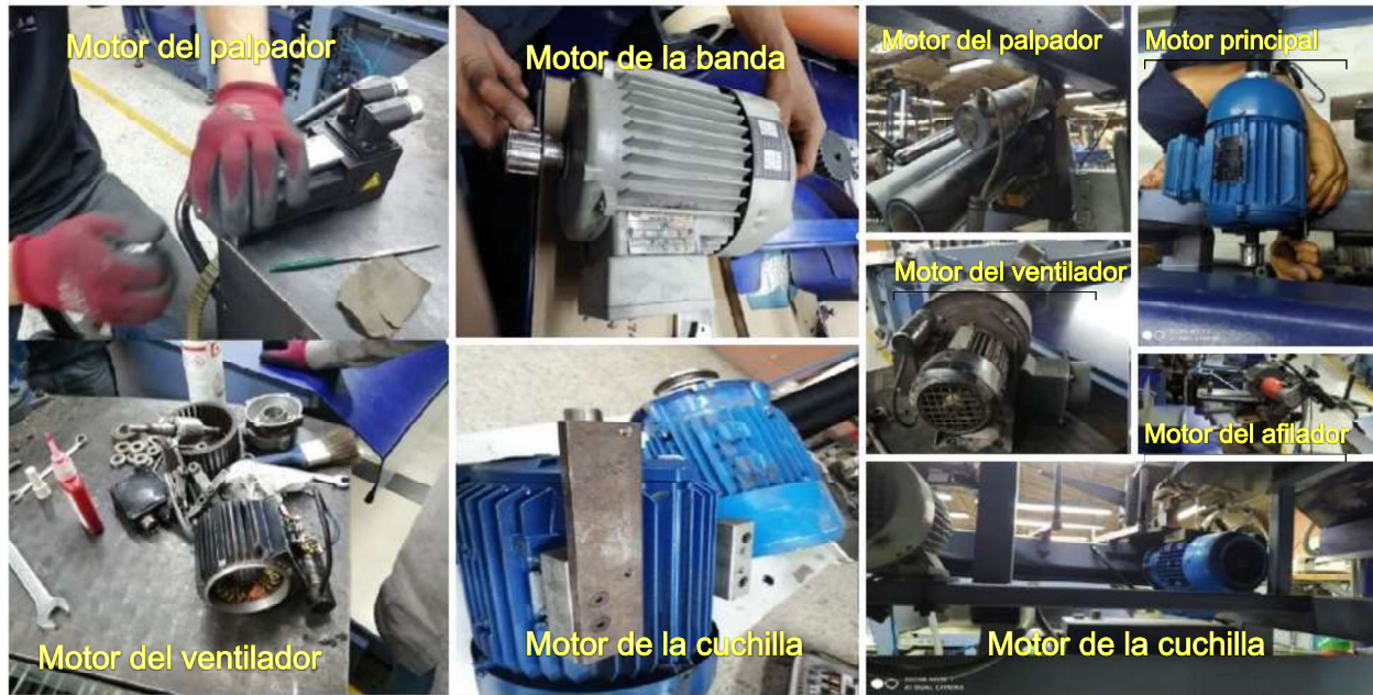
Figura 31 Mantenimiento y montaje de motores. Fuente propia
