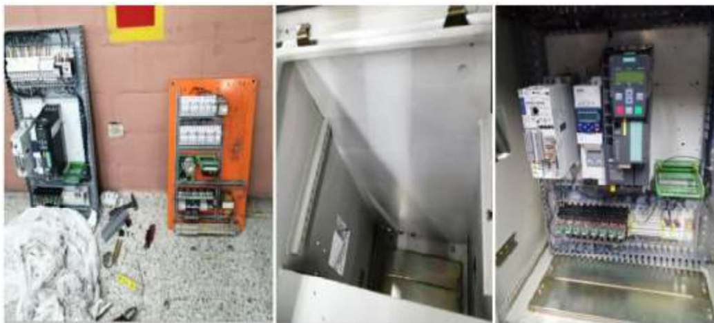
Figura 28 Montaje del nuevo tablero principal. Fuente propia
