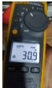
Figura 13 Medición de corriente con pinza amperimétrica Fluke 376. Fuente propia
