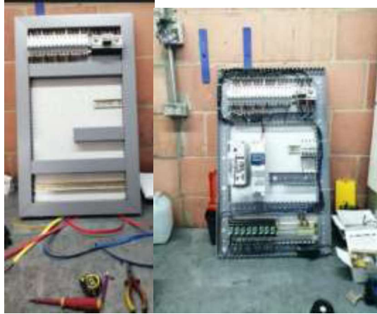
Figura 24 Instalación de Canaleta, riel, protecciones y contactores en el fondo del tablero eléctrico nuevo. Fuente propia
