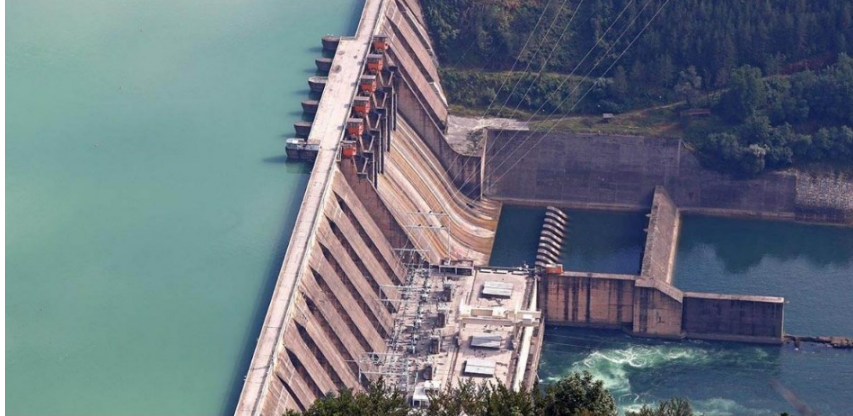
Figura 6: represa e hidroeléctrica
