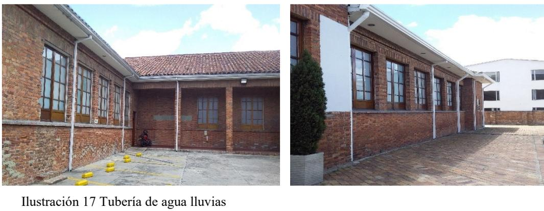
Ilustración 17 Tubería de agua lluvias
