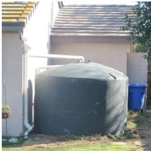
Ilustración 20 Ejemplo del tanque recolector de aguas lluvias
