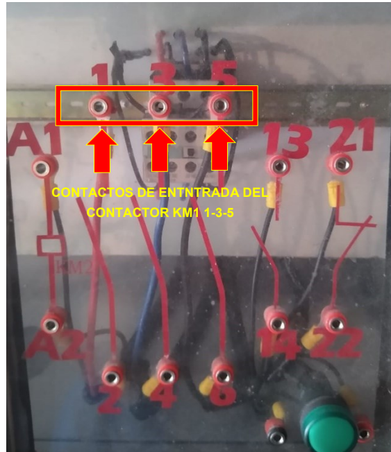
Figura 4-50: Terminales de entrada del contactor KM1
