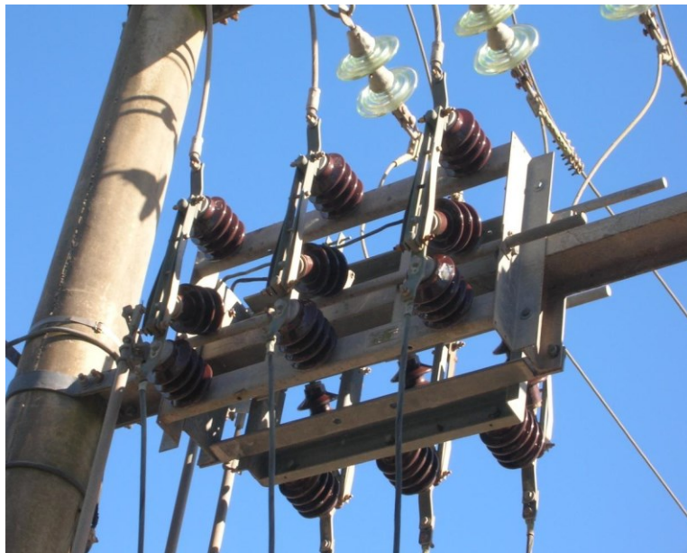
Figura 3. Seccionador tripolar de uso exterior
