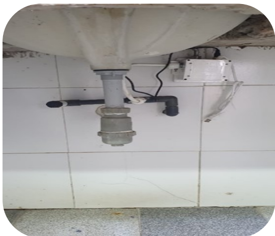
Sistema de alimentacion eléctrico para grifería
