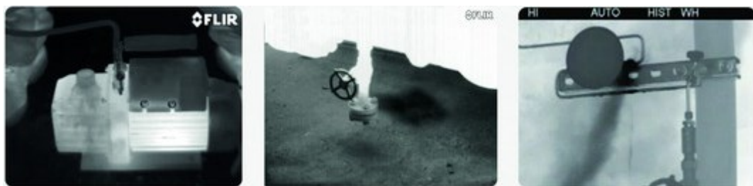
Figura 3. Ejemplos de inspección de fugas en instalaciones industriales (FLIR, GF320 de FLIR utilizada para detectar fugas en instalaciones de biogás, 2019).
