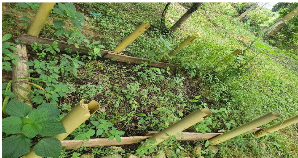
Ilustración 3. Deterioro de camas en el suelo por madera en descomposición.
