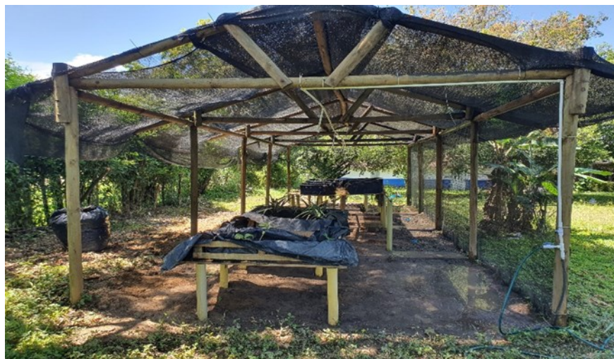
Ilustración 11. Adecuación de polisombra el techo y alrededor de
