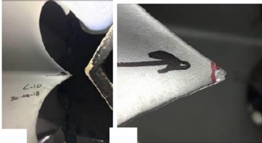
Figura 32. Cangilón 10 con falta de revestimiento en el pico.
