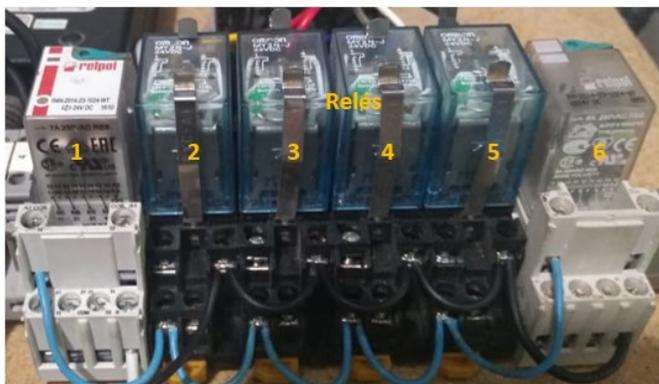
El primer relé tiene la opción de controlar el giro cambiando la posición del neutro en el condensador, lo que hace que el motor gire en uno u otro sentido. Se conmuta entre un contacto normalmente cerrado uno abierto para poder seleccionar a que terminal de condensador conectar, con el relé des energizado el motor gira en sentido horario y cuando se energiza, invierte el giro.
