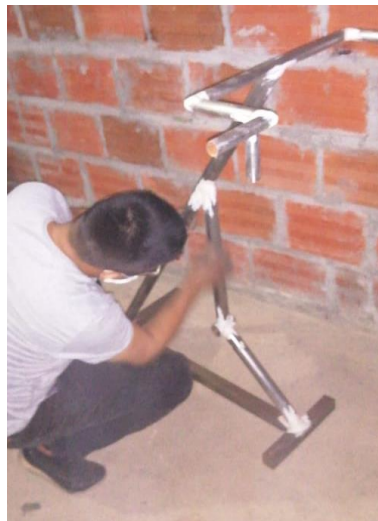
Figura 2- 34 Masillado de esqueleto y pulido de terminaciones soldadas.
