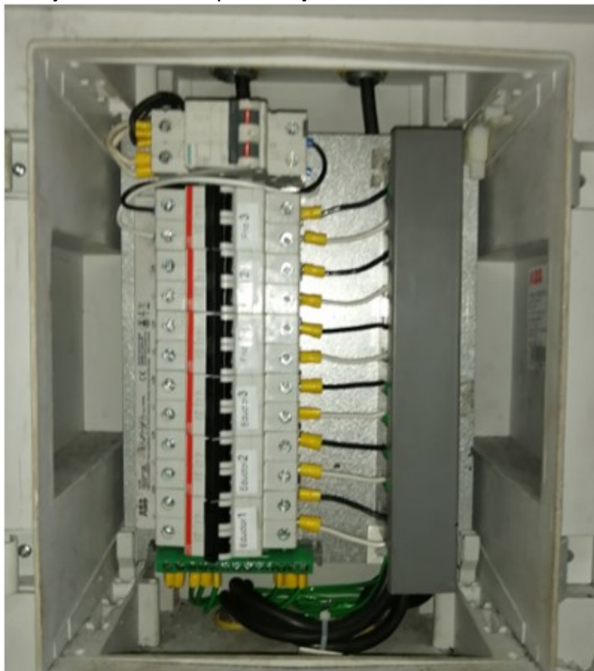
Figura 2-14: Caja de distribución potencia y actuador
