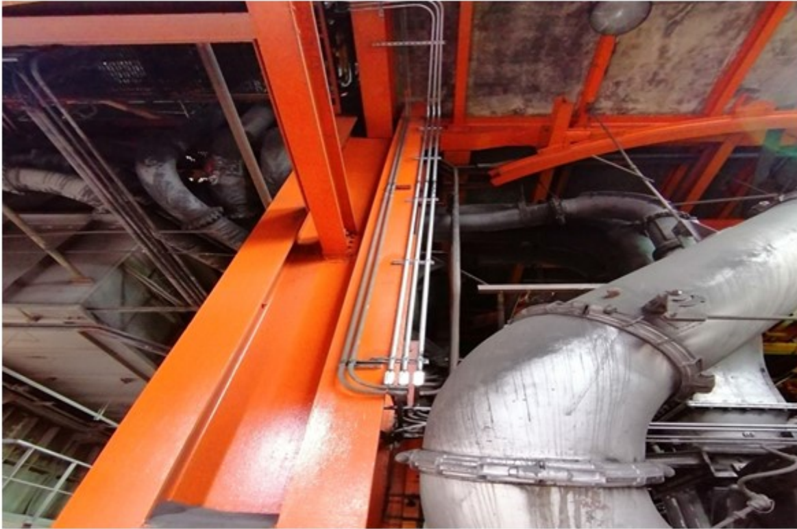
Figura 2-6: Tubería y accesorios instalados
