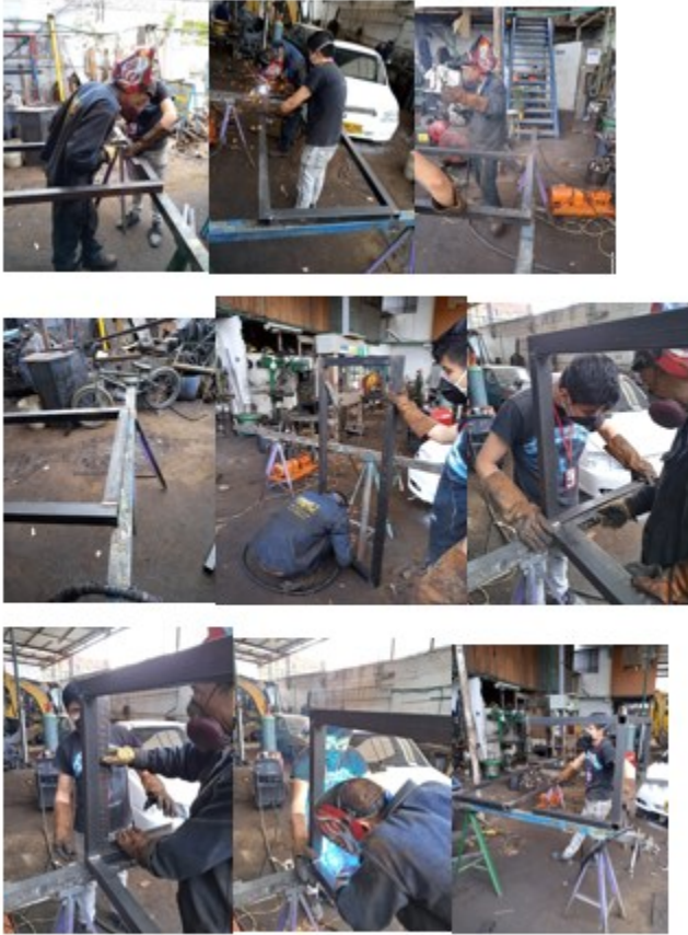
Ilustración 18 Proceso de armado de estructura principal de la máquina
