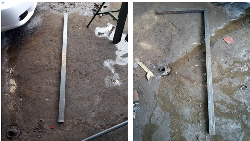
Ilustración 14 Cortes de tramos de tubo estructural
