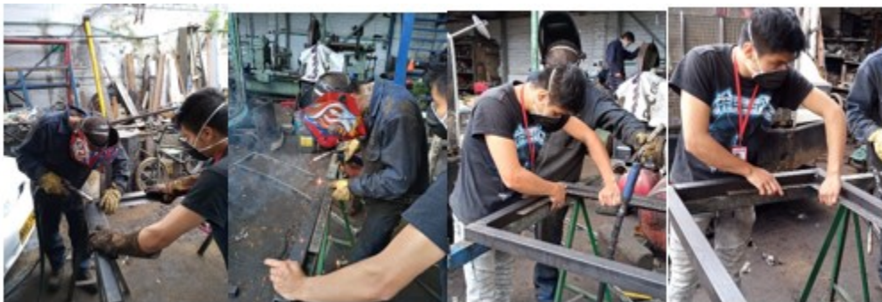
Ilustración 16 Utilización de soldadura MIG para unión de perfiles
