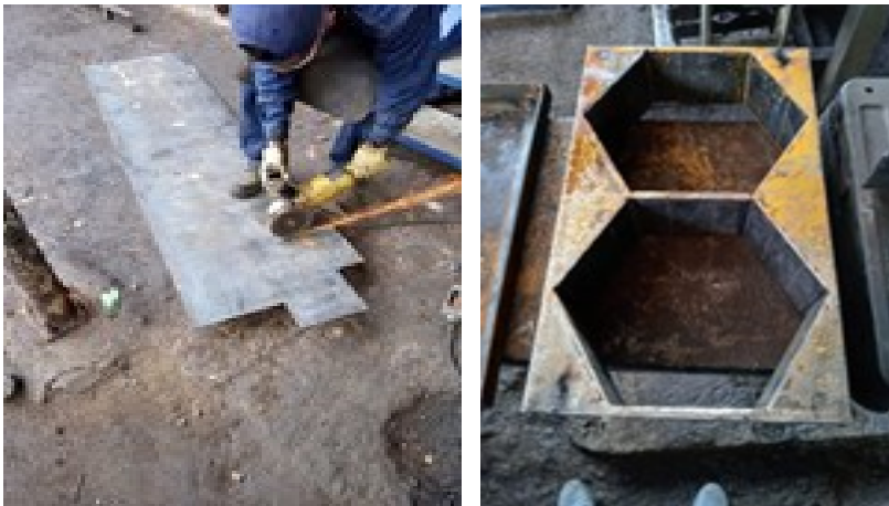
Ilustración 13 Proceso de corte y construcción de moldes
