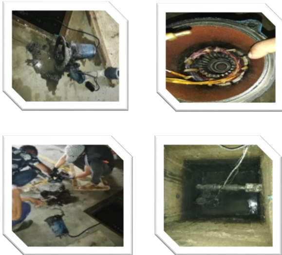
Fig. 11: Reparación de Bomba Averiada
