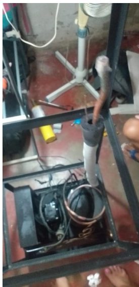
Figura 22: Instalación del compresor y condensador.
