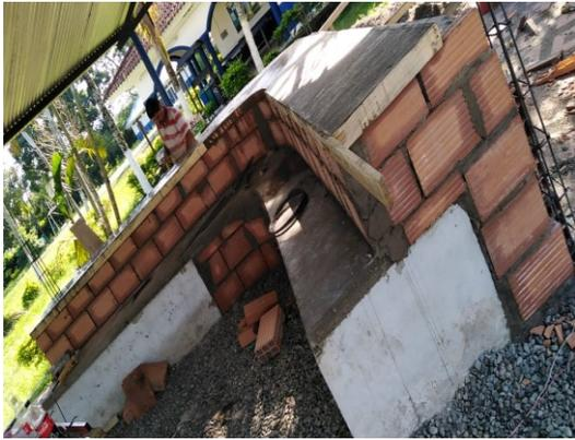
Construcción y fundición de la segunda fila de las gradas.
