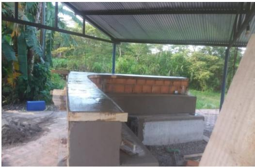
Construcción y fundición de la tercera fila de las gradas.
