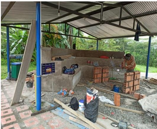
Fundición total de las gradas y construcción de mesón.
