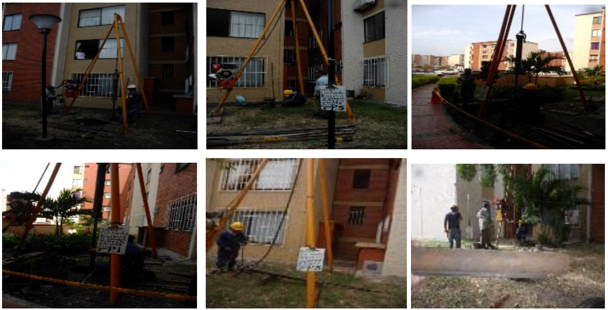
Registro Fotográfico 2 Trabajo en Campo Sondeos
