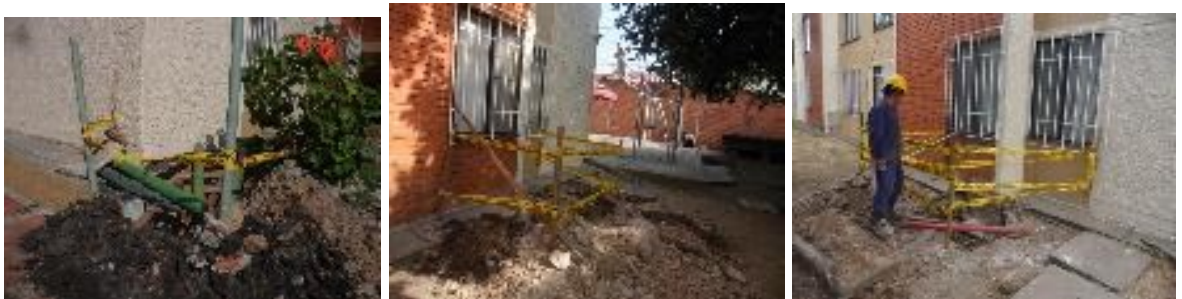
Registro Fotográfico 3 Trabajo en Campo Apiques
