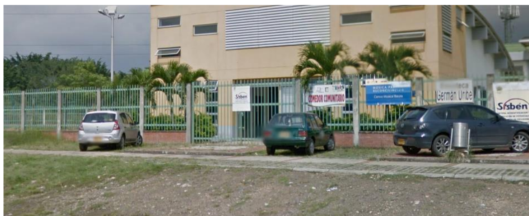
Figura 68. Fachada Equipamiento Existente
