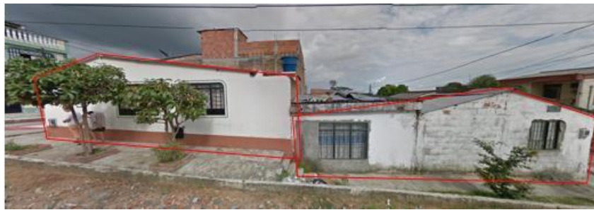
Figura 45. Tipología Viviendas Adosadas del Sector
