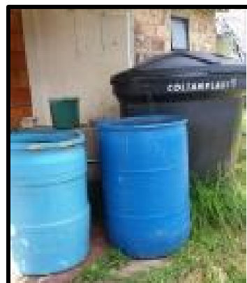
Figura 1-3: Tanque de almacenamiento de agua.
