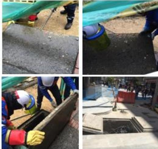
Figura 1: Procedimiento manual levantamiento de tapas. [Fuente propia].
