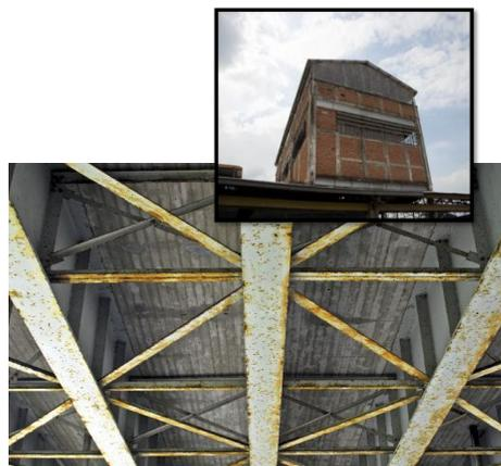
**Ilustración 50.** Estructura Oxidada de Bodega No.06. Fuente: Fotografía propia, (2019).
