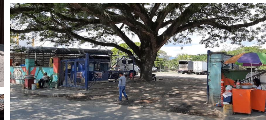
Deterioro del bien patrimonial arquitectónico.
