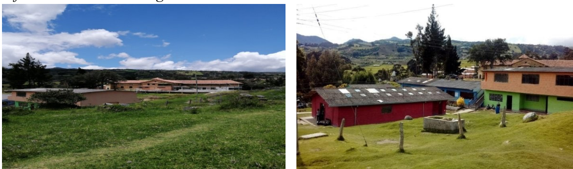
Infraestructura del Colegio de la Universidad Antonio Nariño Usme
